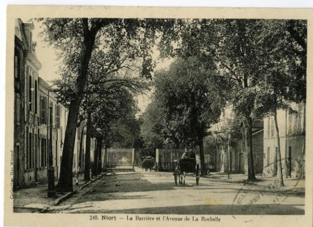
Barrière Avenue de La Rochelle
